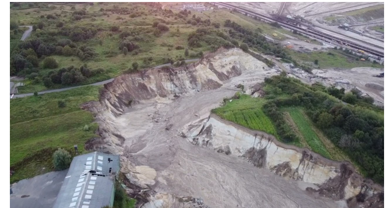
Wassereinbruch in den Tagebau Inden am 15.07.2021
